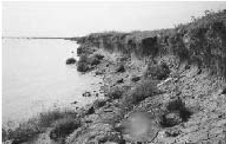
Gambar 1.2 Erosi di Sungai Mahakam
