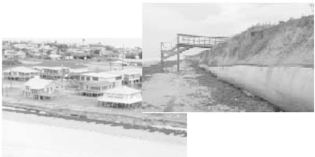
Gambar 1.5 Aplikasi Geotube di Bolivar Peninsular, Texas.
